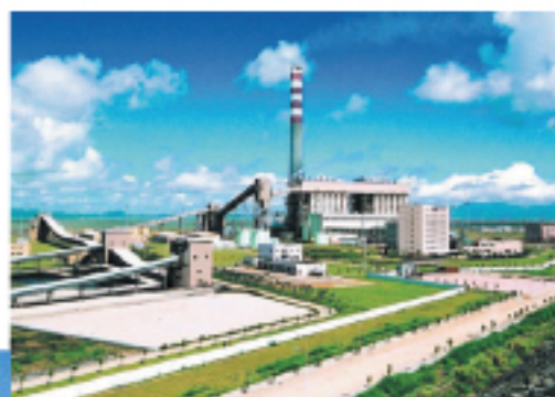
上海临港燃气电厂
