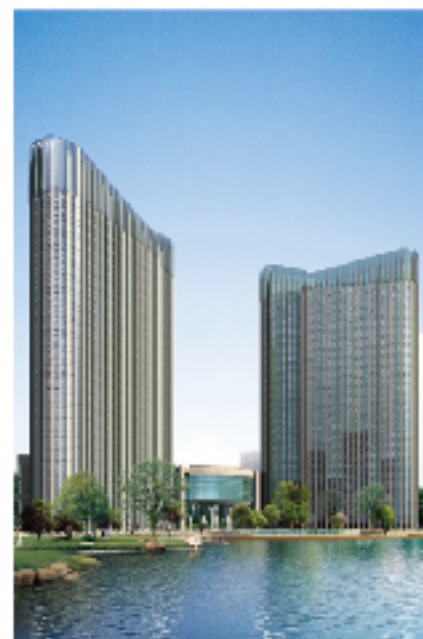
无锡新区科技商务中心
