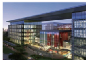
中国人寿上海数据中心
